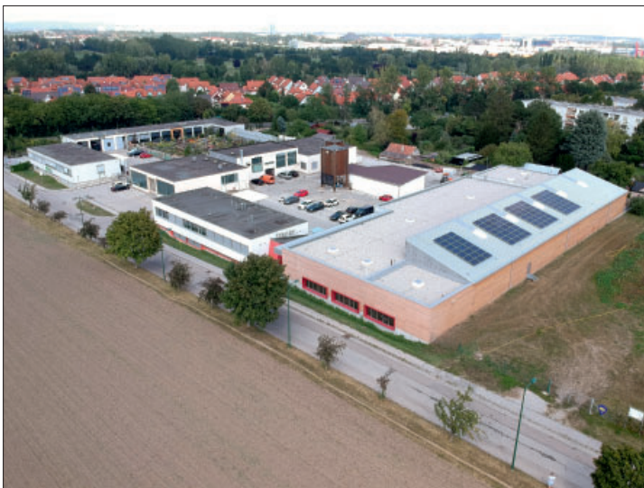
Auf der neuen Halle im Technikzentrum befindet sich eine Photovoltaikanlage.
