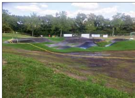
Kurz vor der Fertigstellung.
