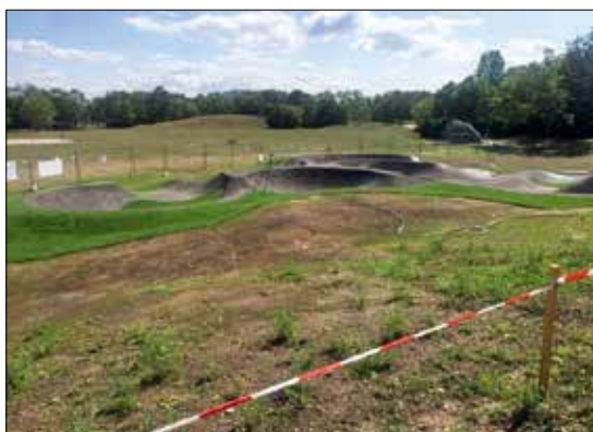
Kurz vor der Fertigstellung.
