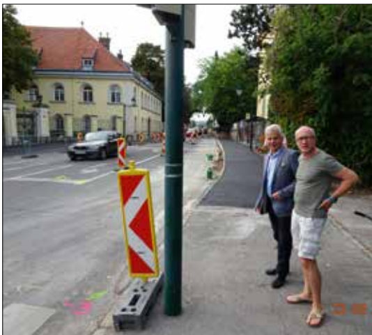
Gehsteig und Bushaltestelle
