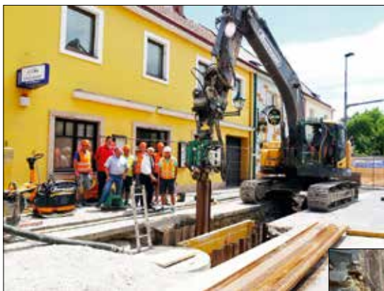
Sperrbrunnen auf der Fahrbahn
