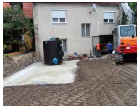
Nach dem Bodenaustausch
