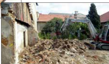
Abbrucharbeiten am Grundstück Hauptstraße 30
