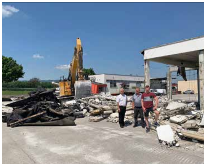
Abbruch der alten Halle
