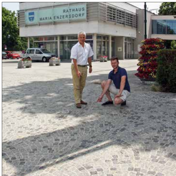
Bei den mit Pflasterungen gestalteten Flächen auf Straßen und Plätzen wurde wie hier beim Rathaus die Verfü-gung mit einem Spezialmörtel ersetzt, um das Herauslö-sen von einzelnen Steinen weitgehend hintanzuhalten.
