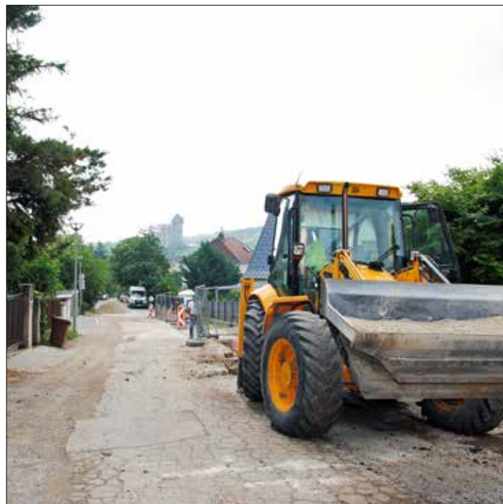
Die Sanierungsarbeiten in der Südtirolerstraße werden noch über den Sommer andauern.
