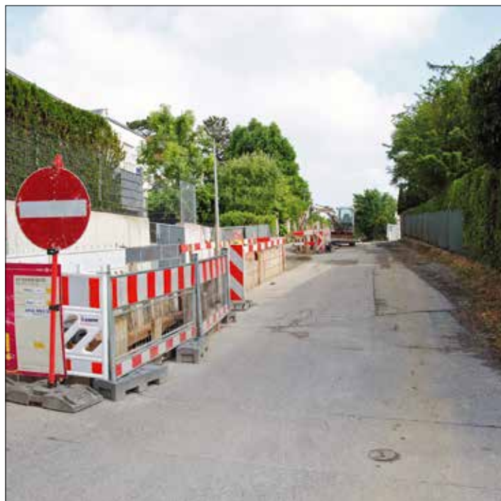
Die Sanierung der Sonnbergstraße startete mit Einbauten der Wiener Stadtwerke.
