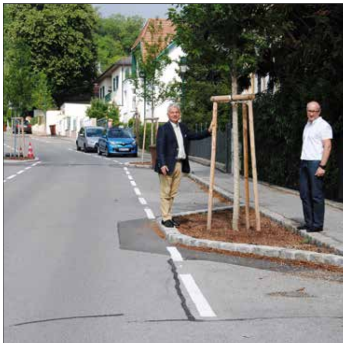
Die Gestaltung der Josef Leeb-Gasse ist mit den Markierungsarbeiten abgeschlossen.
