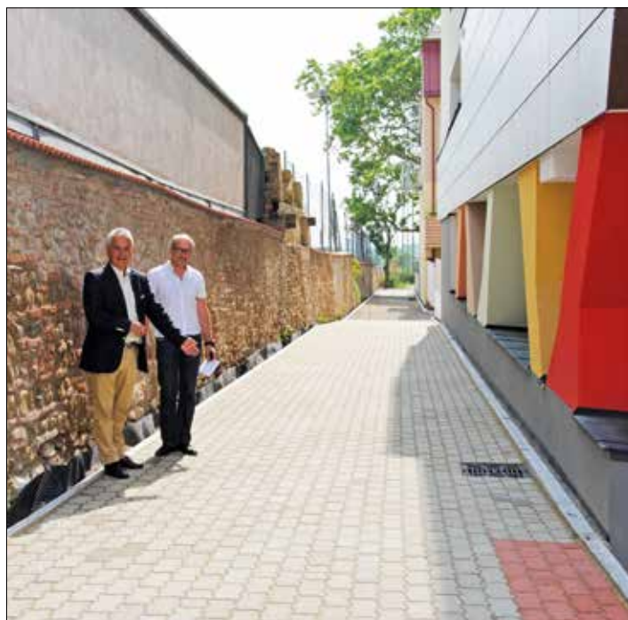
Der erste Teil des neuen Geh- und Radwegs zwischen Hauptstraße und Bahn ist fertiggestellt.
